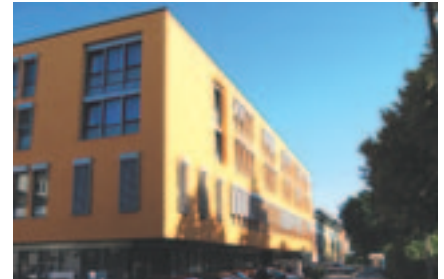
Das Laborzentrum Bremen fasst in einer Public Private Partnership das ehemalige Zentrallabor des Klinikums Bremen-Mitte mit dem LADR GmbH Medizinischen Versorgungszentrum Bremen zusammen.
